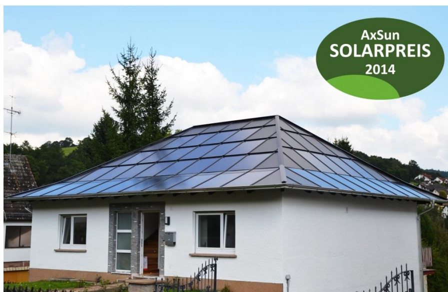
Standort: Altengronau (Hessen), Leistung: 15 kW, Module: AxSun AX P-48 195W (Laminate) mit schwarzen Poly-Zellen
